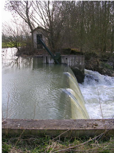
Clapet automatique du moulin de Chevillon
