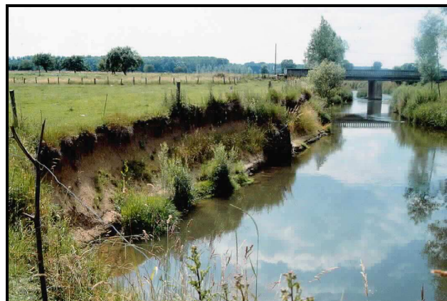
Erosion de berges sur la Nied Réunion en aval du pont de Freistroff (1993)
