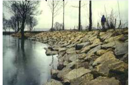
Deux ans après travaux (1994)
