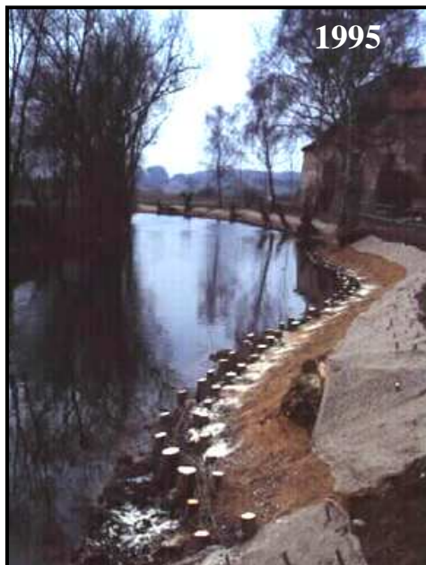
Evolution d'une protection de berge en techniques végétales au Château Saint Sixte à Freistroff
