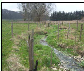
Vues du Weltersbach en 2009, un an après travaux
