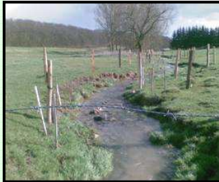
Vues du Weltersbach en 2008 juste après travaux
