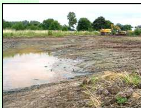
Talutage des berges en pente douce (22/07/2008)
