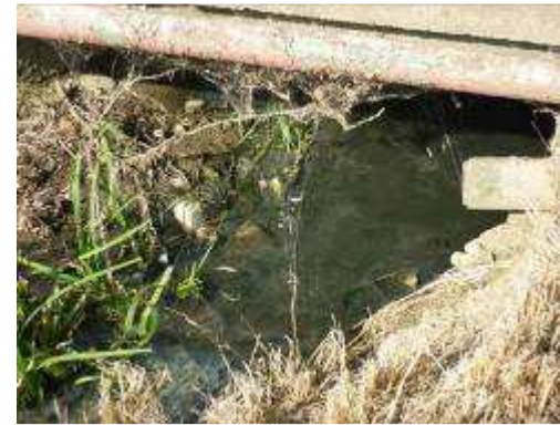
Ph 33 : Aspect de l'eau et du fond du lit au niveau du pont
