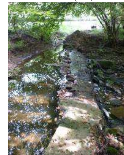
Ph 52 : Prise d'eau pour le moulin de Puttelange / l'eau du Ru d'Himeling est pratiquement dirigée dans sa totalité vers le canal d'aménagé du moulin
