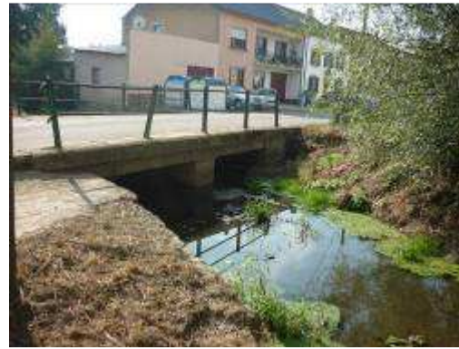
Ph 26 : Pont à Himeling (annexe de Puttelange-lès-Thionville)
