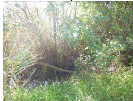
Ph 15 : Berge de faibles hauteurs (<50cm)
