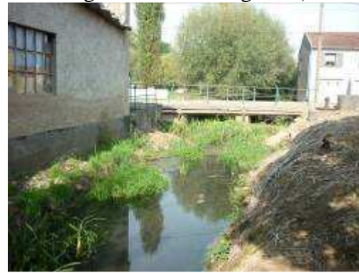
Ph 32 : Vue générale en aval du pont
