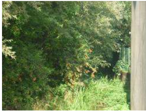
Ph 25 : Vue en amont du pont
