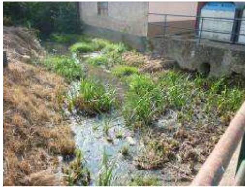
Ph 30 : autre vue en aval du pont (rejet domestique)
